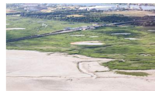
Aux marées de vives eaux, l'eau de la Seine inonde les prairies via les ouvrages jalonnant la digue de la Route de l'Estuaire
